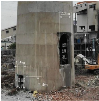
图 3 底部人孔及烟道孔相对位置
