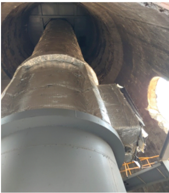
图 6 钢内筒底部现场图
