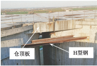
图 3 筒仓顶部 H 型钢连接图
