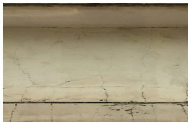
图 1 墙-顶连接处裂纹
