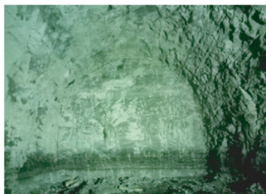
图11 现场试验围岩爆破成型效果图
