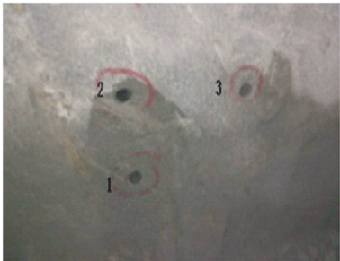
图5 声波孔现场布置
