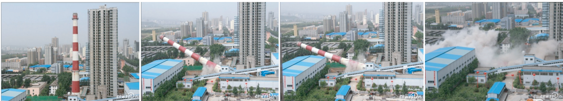
图 6 烟囱爆破倒塌过程 Fig. 6 Blasting collapse process of the chimney
