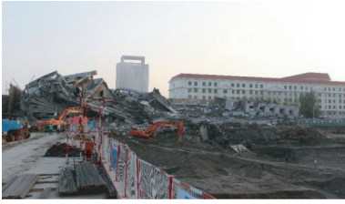
(a) 东、西部向中部定向倾倒合拢解体
