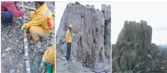
图 2 PVC 管注水爆破施工方法及效果
