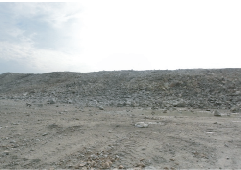
图 4 ▽ 825 平台爆破效果 Fig. 4 Blasting effect of ▽ 825 platform
