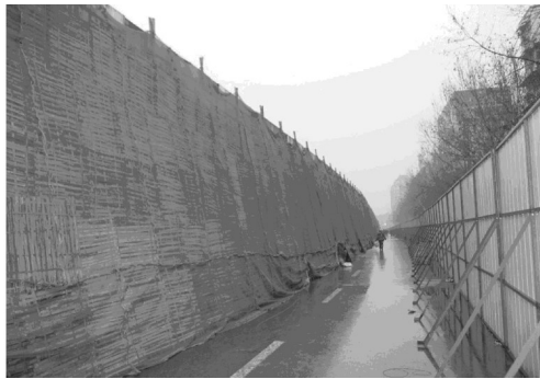
图 11 爆破前桥侧密目安全网
