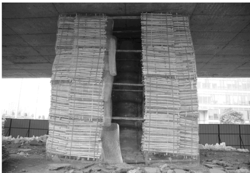
图 9 柱墩的外围防护
