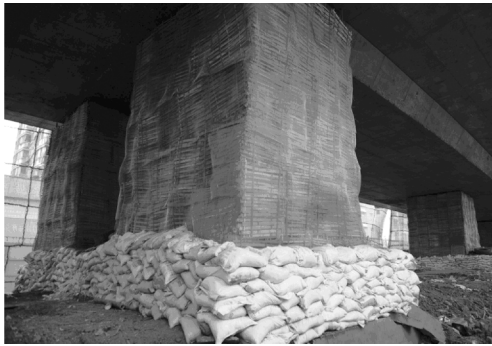
图 10 在桥墩周围铺设沙袋
