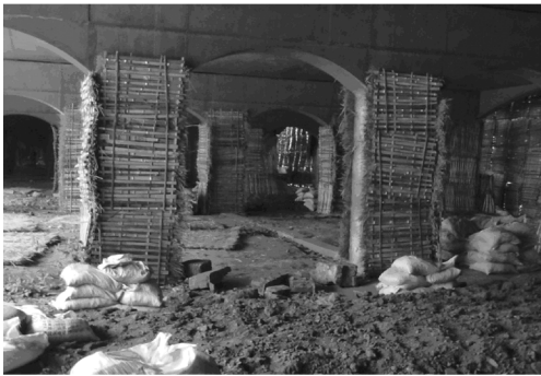
图 6 门式墩的近体防护
