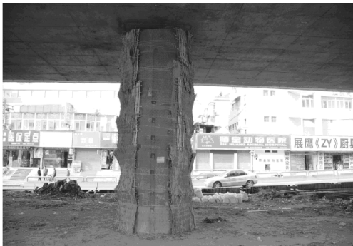
图 8 柱墩的近体防护
