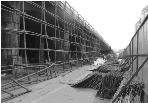
图 7 门式墩的外围防护
