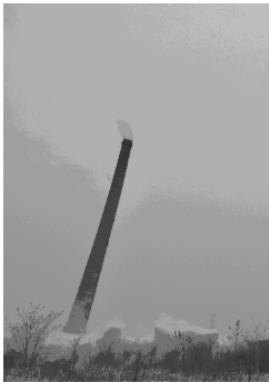
图 2 烟囱断裂图
