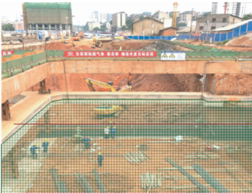
图3 空中隔离防护措施
