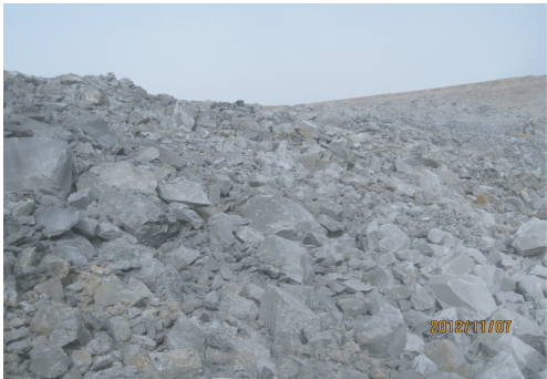
图 3 RTK 布孔爆破效果
